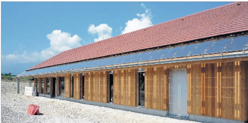
Le bâtiment très allongé et ses panneaux photovoltaïques.
